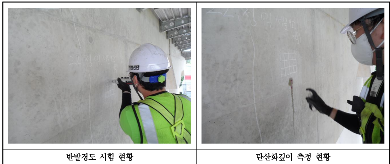
【사진 9.4.1】 콘크리트 내구성조사 현황
