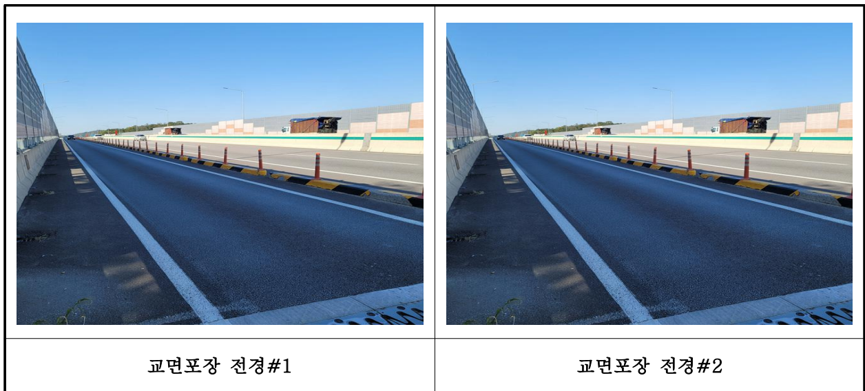
【사진 9.3.19】 교면포장 전경
