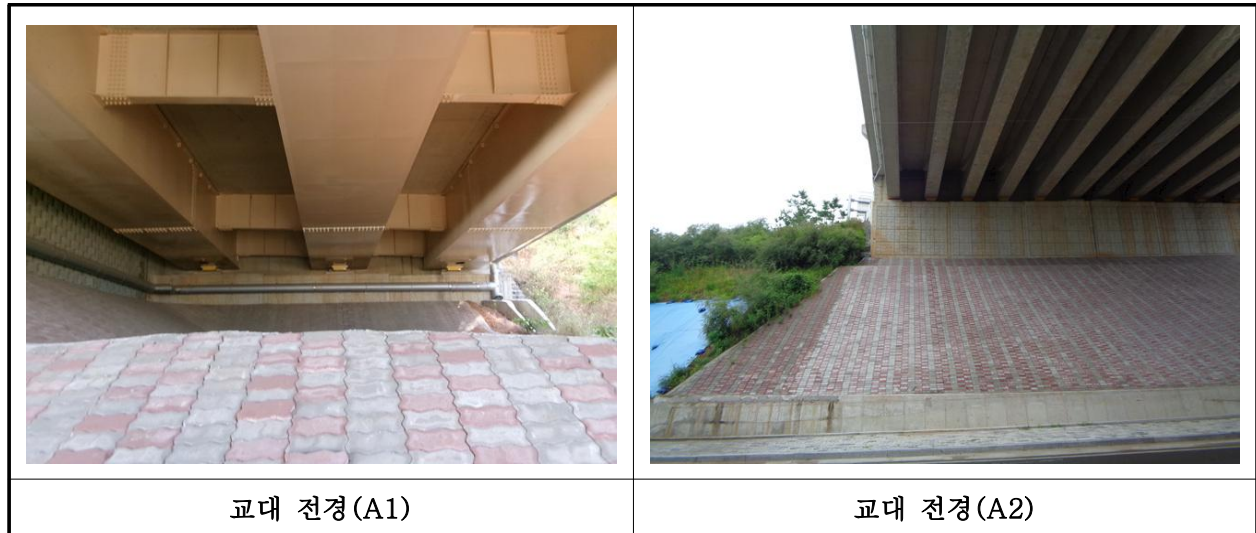
【사진 9.3.8】 교대 전경
