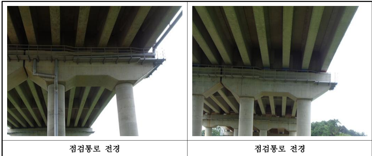
【사진 9.3.25】 교량 점검시설 전경
