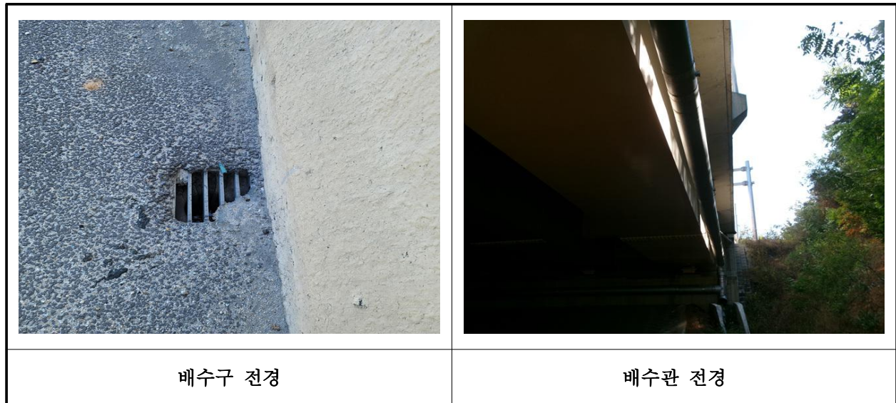
【사진 9.3.21】 배수시설 전경
