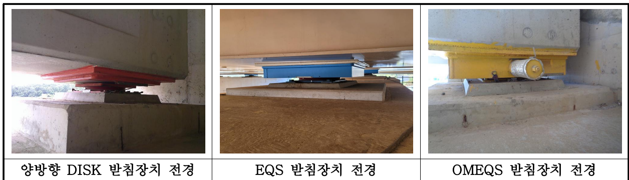
【사진 9.3.12】 교량받침 전경
