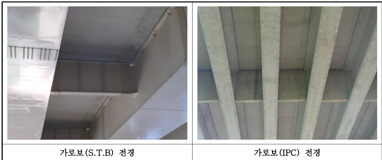
【사진 9.3.6】 가로보 전경
