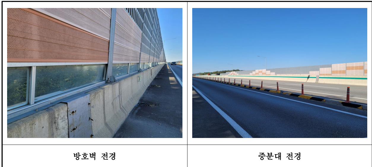
【사진 9.3.23】 방호벽 및 중앙분리대 전경
